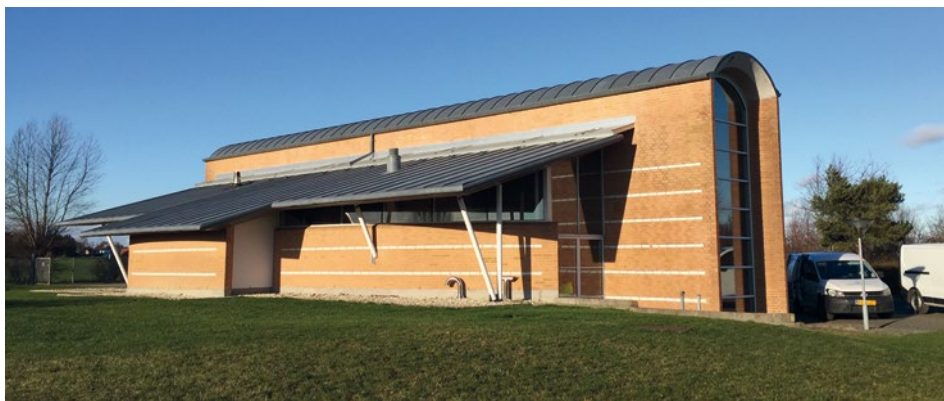
El trabajo científico se llevó a cabo en Lundeværket, perteneciente a Vandcenter Syd, en Dinamarca, que es una planta de tratamiento de aguas típica del país nórdico.
